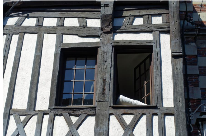
Exemple de baies étroites et jumelées
